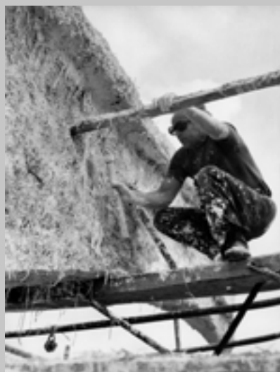
PRACE PRZY REALIZACJI „POMNIKA ŻOŁNIERZY POLSKICH” W KATOWICACH (1977)
